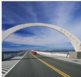
澎湖跨海大橋
